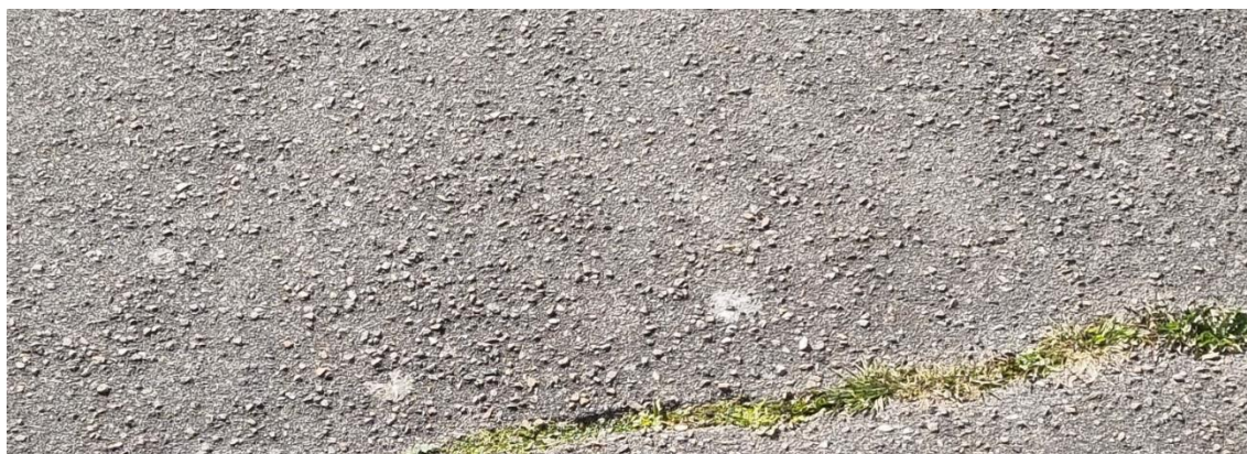
Figur 10 - Stentab og udtørring af belægningen - billede fra Trelleborgvej - Jomsborgvej
